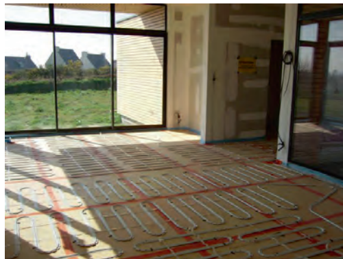
↑ Isolation du sol et intégration des serpentins électriques pour le chauffage
