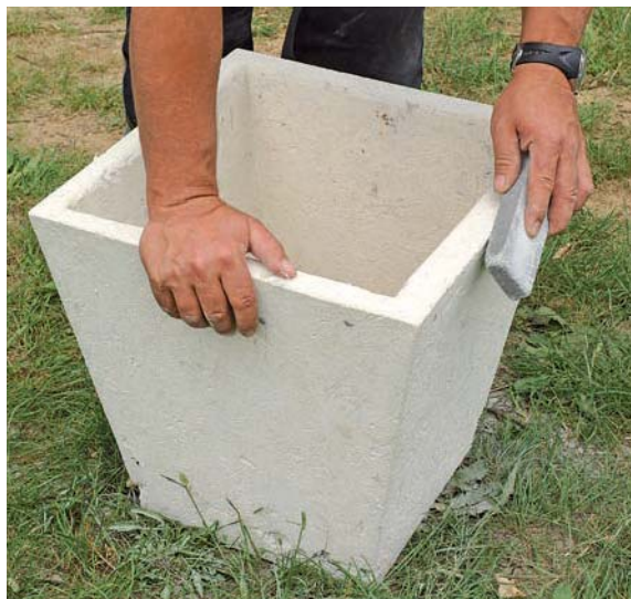
8 Poncez les arêtes et d'éventuelles irrégularités avec une pierre à poncer de maçon.
