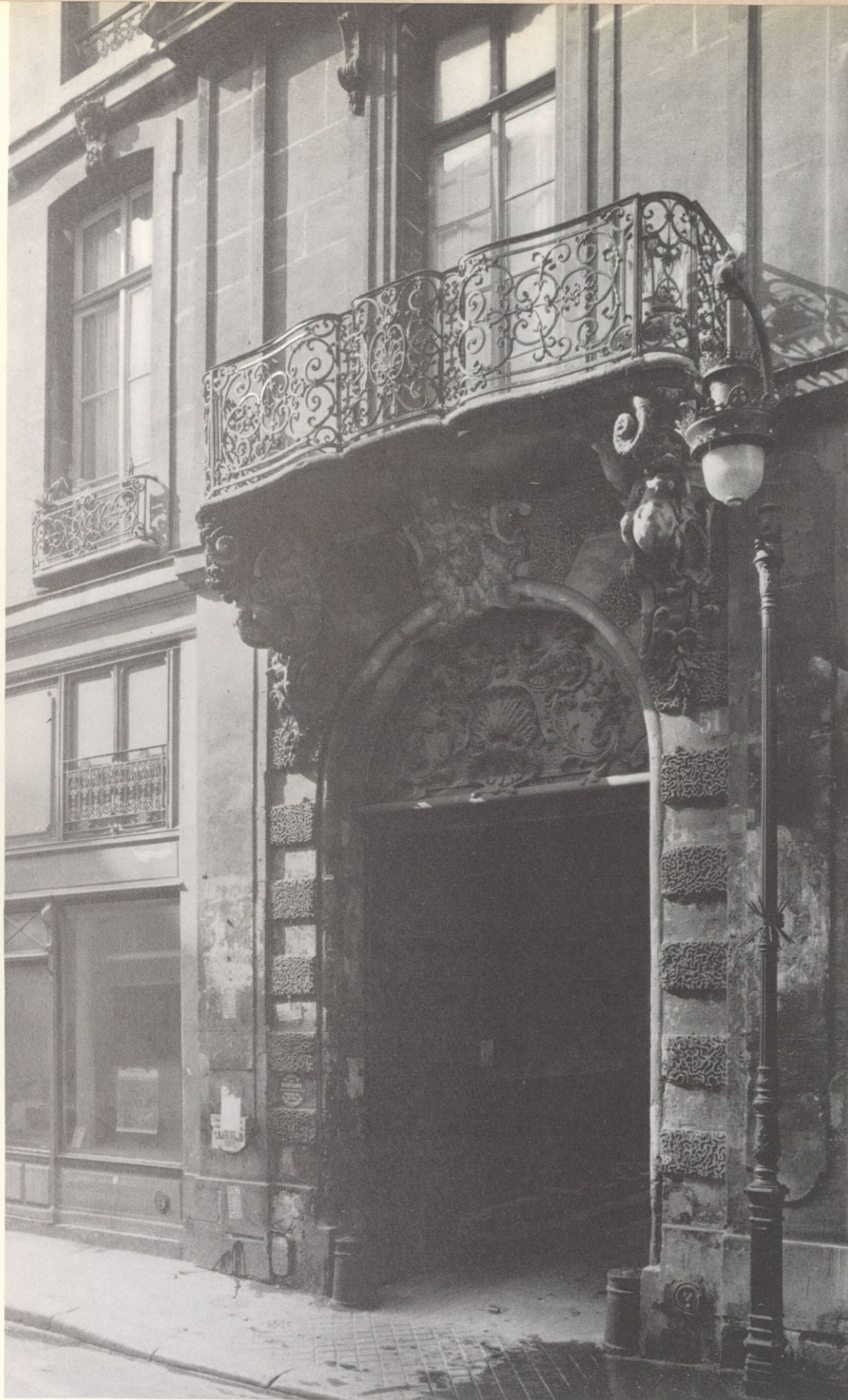
HÔTEL CHENIZOT, 51, rue Saint-Louis-en-l'Île, bâti par P. de Vigny pour J. F. Guyot de Chenizot.
