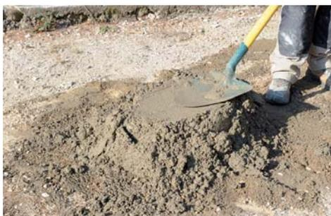
**11** Passez le plat de la pelle sur le mortier. Lorsqu'il est bien humidifié, il se lisse et l'eau remonte en surface.
