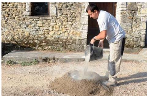
**3** Déposez le ciment (ou la chaux) sur le sable. Deux seaux dans notre exemple.
