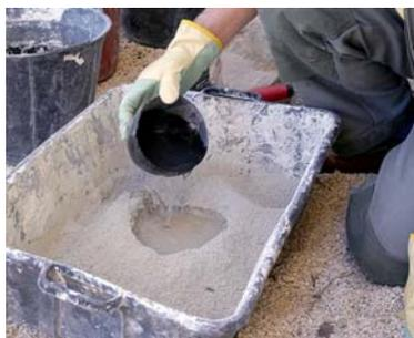
**6** Mélangez intimement pour obtenir un mortier consistant et homogène. Quand vous posez la truelle à plat sur le mortier, il se lisse et l'eau remonte à la surface.
