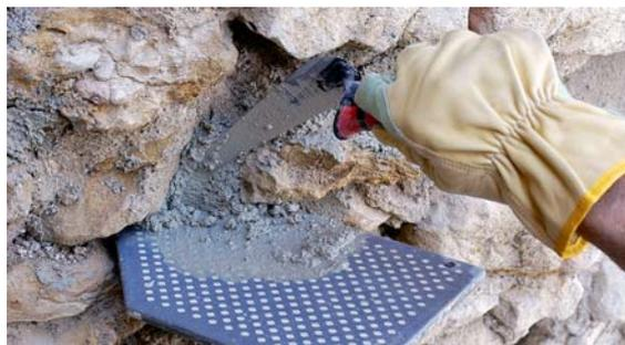
**4** Une petite taloche permet d'apporter le mortier dans les trous du mur.
