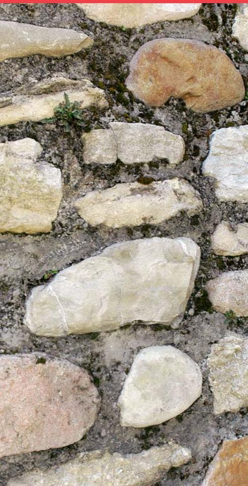
*La rénovation des joints est importante pour l'esthétique, mais elle est surtout essentielle pour des raisons techniques: sur un mur extérieur, les joints doivent être étanches pour empêcher le passage de l'eau de pluie; sur un mur intérieur, il s'agit surtout d'éviter la poussière.*
