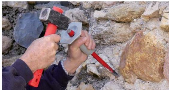
**2** Pour les parties plus dures, n'hésitez pas à utiliser le ciseau de maçon et la massette.
