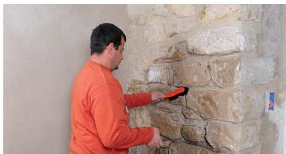
**4** Humidifiez abondamment les joints avec une brosse, ce qui permet, en même temps d'éliminer les particules mal adhérentes.
