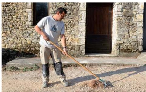
**1** Le mortier doit être mélangé sur une surface «propre», c'est-à-dire sans herbe ou débris végétaux.
