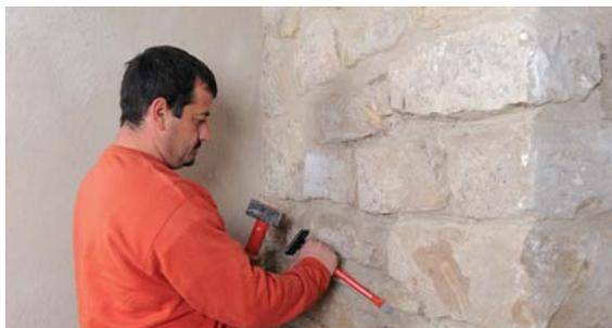
**1** Creusez profondément (25 à 30 mm au moins) les joints existants au burin et à la massette.
