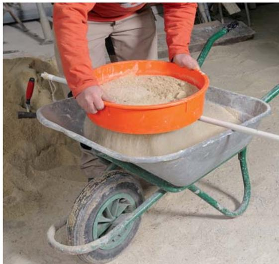
2 Une bonne technique pour tamiser, consiste à déplacer le tamis, dans un mouvement de va-et-vient, sur un manche à balai qui roule sur les côtés de la brouette.
