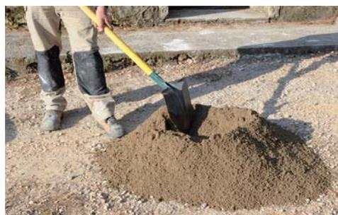
**2** Déposez sur l'aire de gâchage le sable. Par exemple, cinq seaux pour du mortier de construction.
