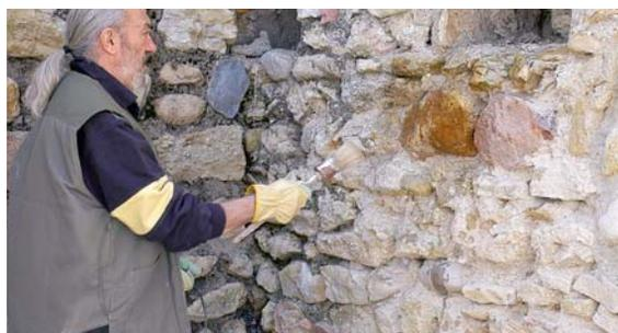
**6** Mouillez abondamment le mur pour que le mortier de jointoyage accroche et ne sèche pas trop vite.
