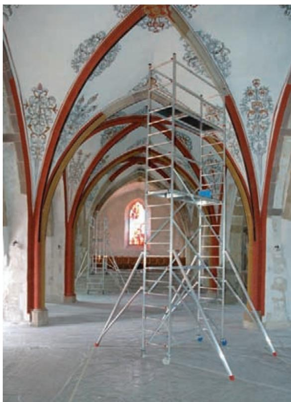
Fig. 6 Vue d'un échafaudage roulant en position.
