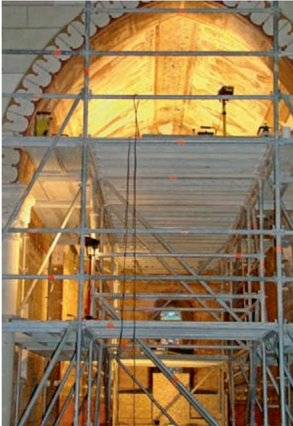
**Fig. 8** Vue d'un échafaudage fixe monté à l'intérieur d'une architecture romane. La difficulté réside dans le fait de donner accès à toutes les parties du mur et de la voûte.
