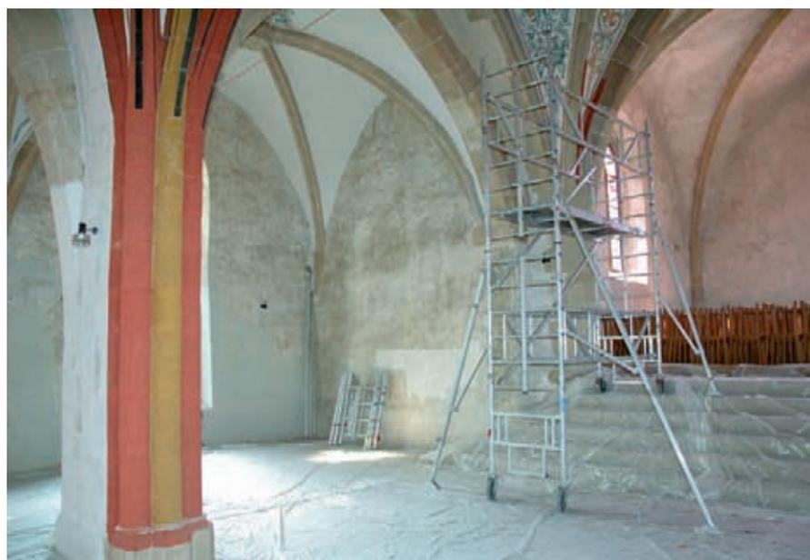
Fig. 7 Vue d'un échafaudage roulant placé sur un escalier : sa grande maniabilité permet de l'utiliser pour travailler dans les endroits plus difficiles d'accès.
