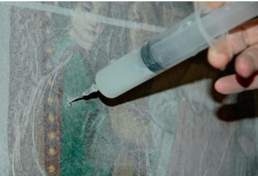
Fig. 18 Vue d'une injection dans le mur.
