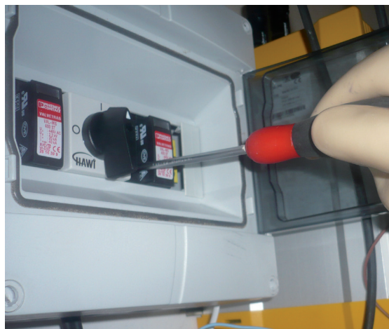
Intervention sur un coffret électrique.
