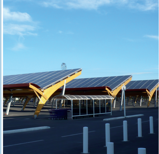
Inaugurée en 2008 à Saint-Aunès (Hérault), cette ombrière photovoltaïque dont la production est injectée au réseau électrique présente une surface de captage de 8000 m 2 . (photo des auteurs)
