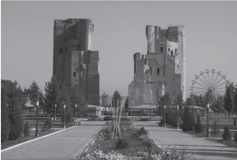
Figure 1.7 Les « pylônes », montants de la porte du palais de l'Ak Saray à Shahrissabz.
