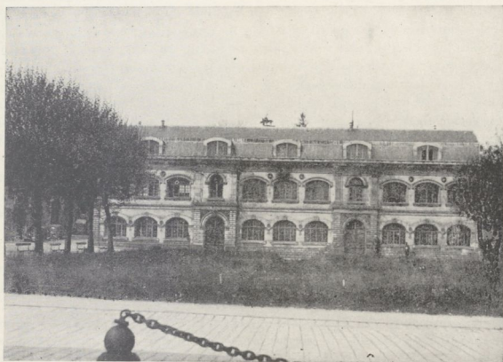
Fig. 10. — Façade du bâtiment des « études et tirs ».
