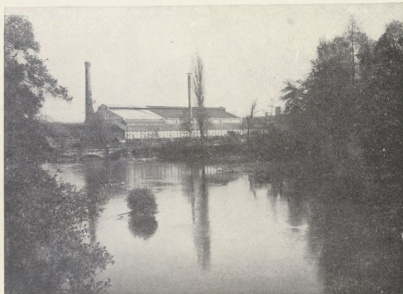
Fig. 15. — La station centrale et les ex-nouvelles grandes forges, vues des Ribéraux. (Cliché BELLUTEAU).
