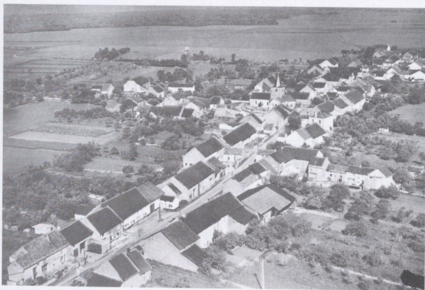
Blessonville (Haute-Marne). Vue générale aérienne
