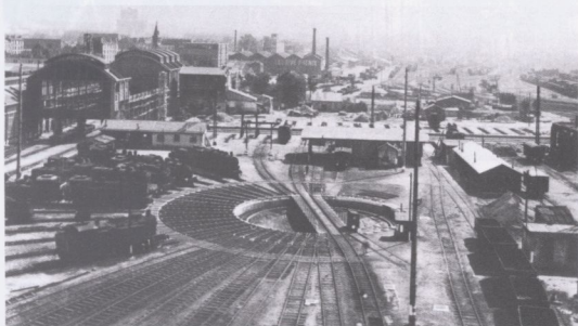
Le dépôt de la rue du Bailly en reconstruction après les bombardements d'avril 1944.
