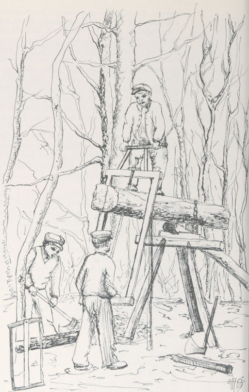
Les scieurs de long étaient les compagnons des bûcherons et les auxiliaires des charpentiers. Ils venaient souvent par équipe du Massif central (Dessin M. Bitschenaux).
