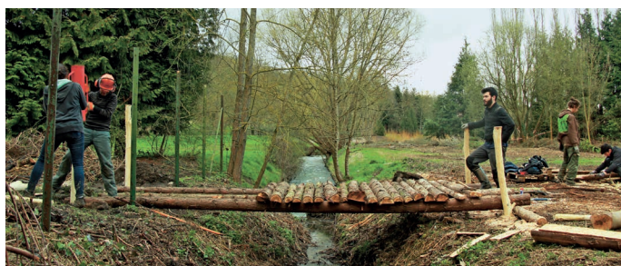
Livrer le bois d'œuvre à bon port. Atelier "Conduire le vivant", Igny, fustiers en chemin de passerelle.
