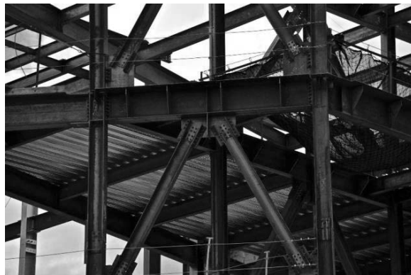
Figure 8 : vue inférieure d'une dalle mixte coulée sur une tôle nervurée. Photo de Orest Ukrainsky
