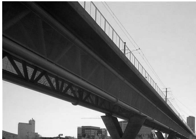
Figure 6 : la poutre métallique n'est pas nécessairement un profilé mais peut-être, comme ici, une poutre treillis, photo de Alan Levine
