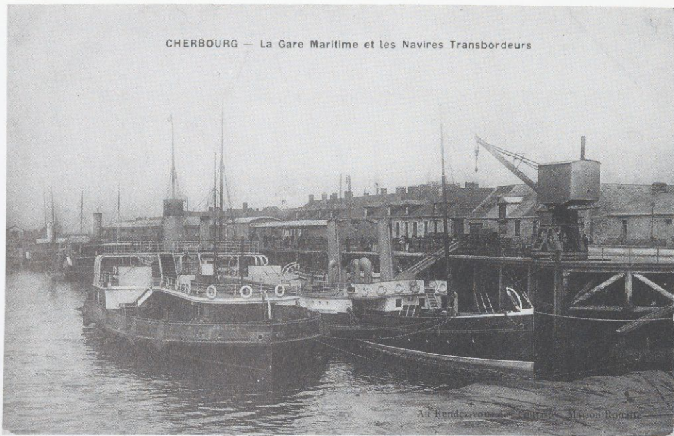
La première gare maritime avec, à l'arrière-plan, les bâtiments de l'ancien arsenal.
