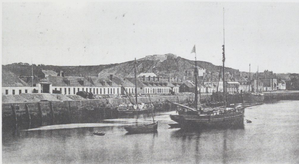
Vue de l'avant-port avant les installations du port transatlantique.
