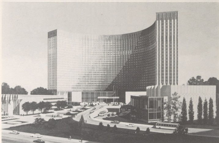
FIG. 47. — Hôtel Cosmos, à Moscou. Façade interne du bâtiment en arc de cercle.
