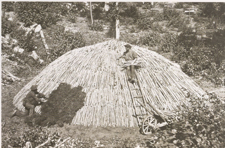
Fabrication du charbon de bois. Le montage de la meule. Phot. J. Boyer.
