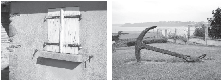
Figure 1 | Photographies de deux cas de corrosion rencontrés en bord de mer.
