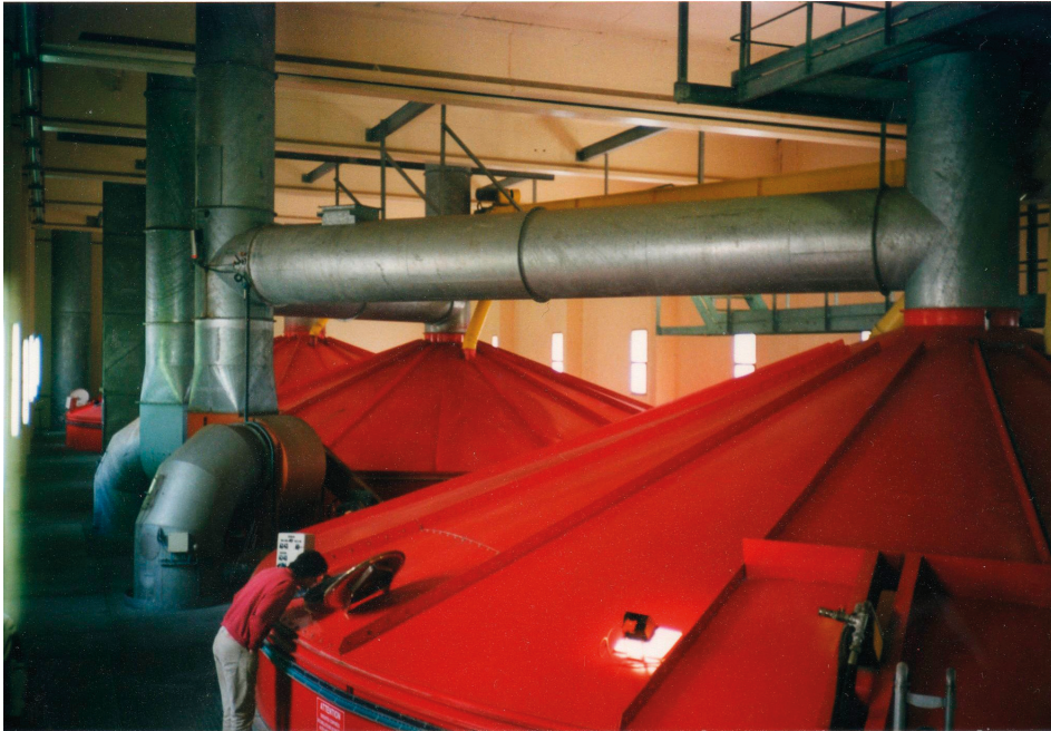
Cuves de trempage de la malterie Soufflet à Pithiviers.
