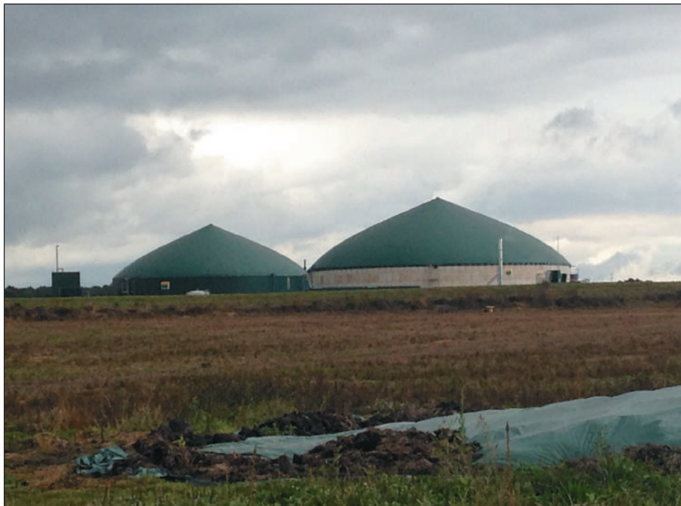
Photo 13.2: Une installation de méthanisation
