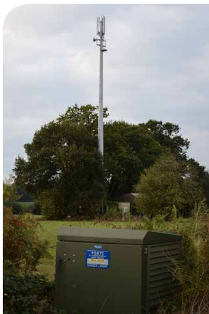
Photo 9. Antenne de téléphonie et transformateur EDF.
