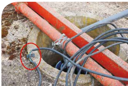
Photo 50. Tête de forage avec défaut d'isolement.
