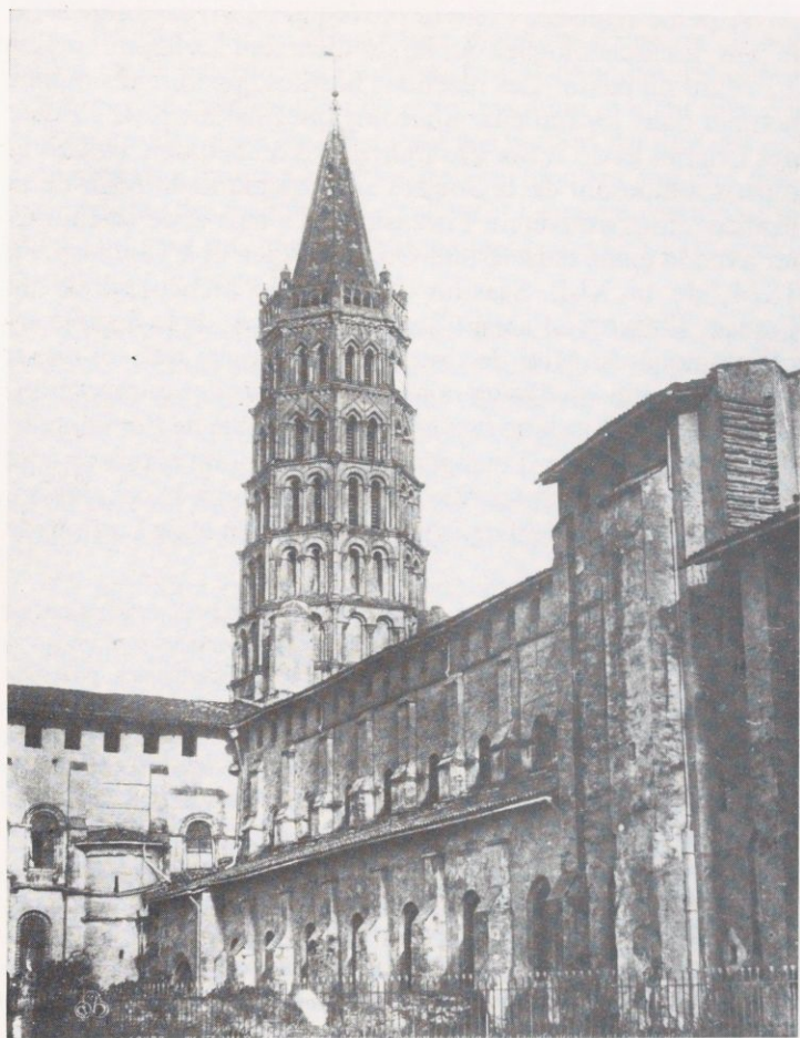
ÉLEVATION NORD DE LA NEF AVANT RESTAURATION
