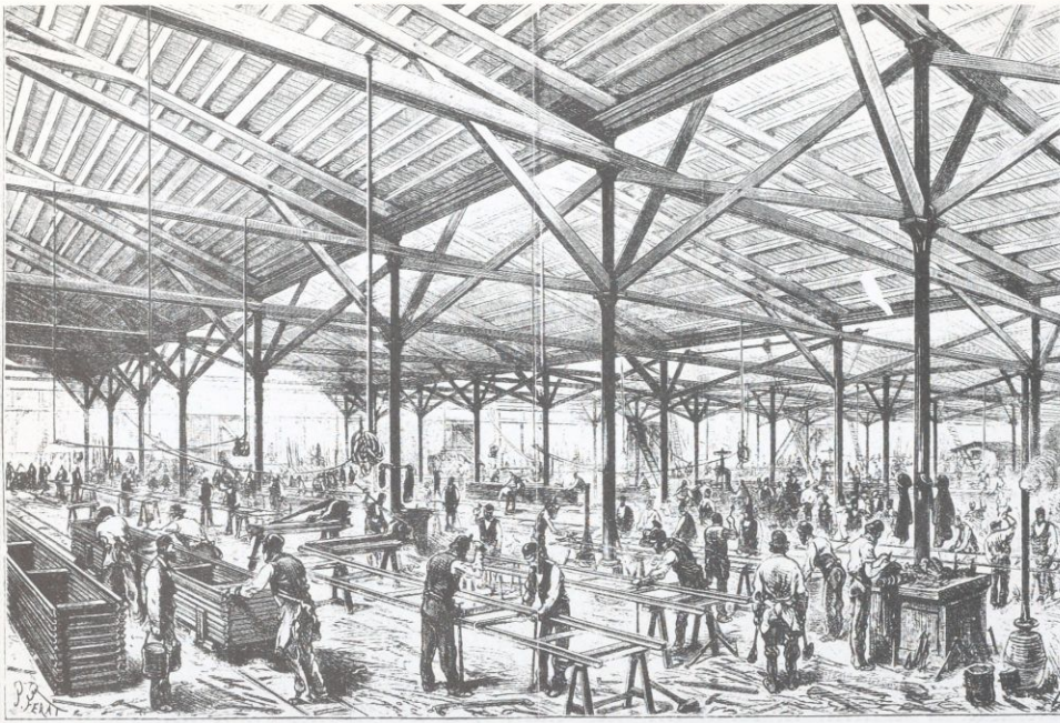
Une des rares vues que l'on connaisse des ateliers Decauville établis à Evry Petit Bourg et encore est-ce une vue intérieure de l'atelier qui venait d'être installé pour la fabrication des voies portatives, en 1877. Dessin de Ferat, illustrant l'ouvrage de Turgan. (Archives Départementales de l'Essonne).
