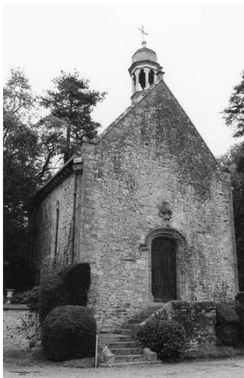
Chapelle des Geffrard, château de Boiscornillé à Val d'Izé.
