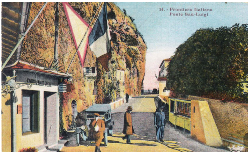
Ci-contre : Pont Saint-Louis (avant 1940) vu de la casemate Collection Roger MARCEL
