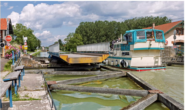
Pont tournant sur le canal Marne-Rhin, près de Strasbourg.
