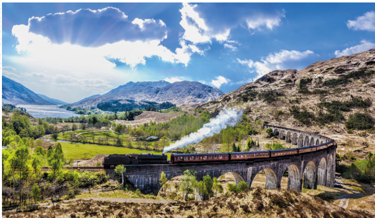
Le viaduc de Glenfinnan, dans les Highlands, mesure 15 mètres de haut et apparaît dans les films de la saga Harry Potter.
